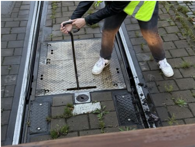
Am Bürgerpark musste zunächst die Weiche für die Weiterfahrt gereinigt werden. (BH)
