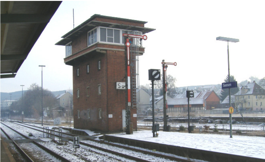
Das Stellwerk am Bahnhof Seesen
