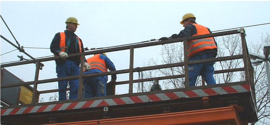
Die Strecke war kurz zuvor stromlos gemacht worden, indem die Fahrleitungswerkstatt den Fahrdraht für beide Richtungen in Höhe des Kalenwalls geerdet, durchtrennt und isoliert hatte.
