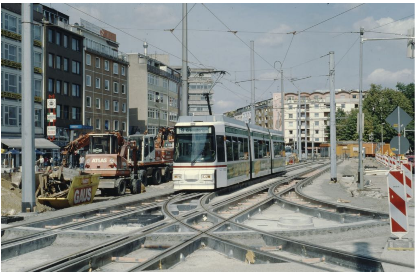
Auch die 95er Niederflurstraßenbahnen wurden auf der Linie 9 eingesetzt, wie der Tw 9552 inmitten der Bohlweg-Sanierung im Jahr 2005.
