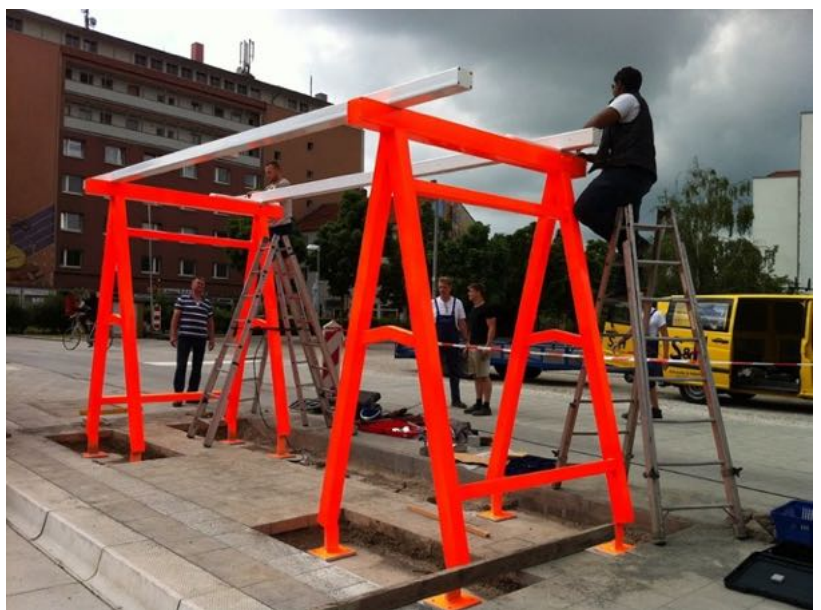
Einbau des Wartehäuschens 2013.
